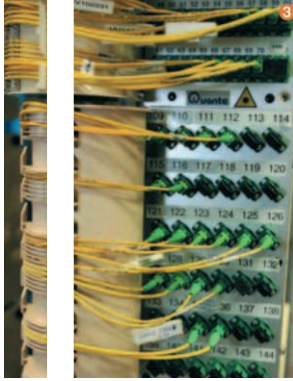
موزع المعطيات الذي يسمح بربط دعومات المعطيات بمبدل المعطيات.
