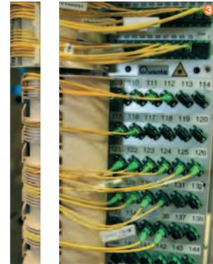
Répartiteur de données permettant de connecter les supports de données au commutateur de données.
